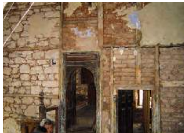
Εικ. 59. Δεσιές και τοιχοποιίες στο αρχοντικό Βούρκα-Κατσικά.
